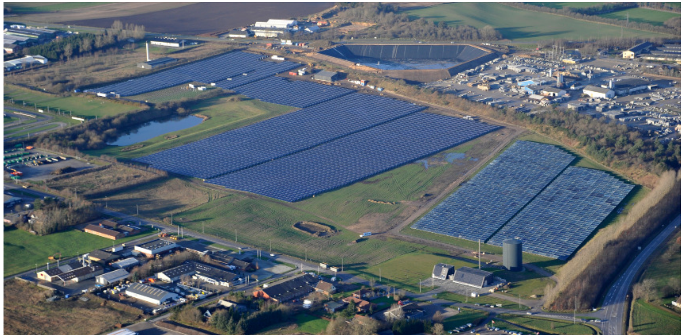
Pt. verdens største solvarmeanlæg har bragt Vojens helt frem i det grønne felt.
