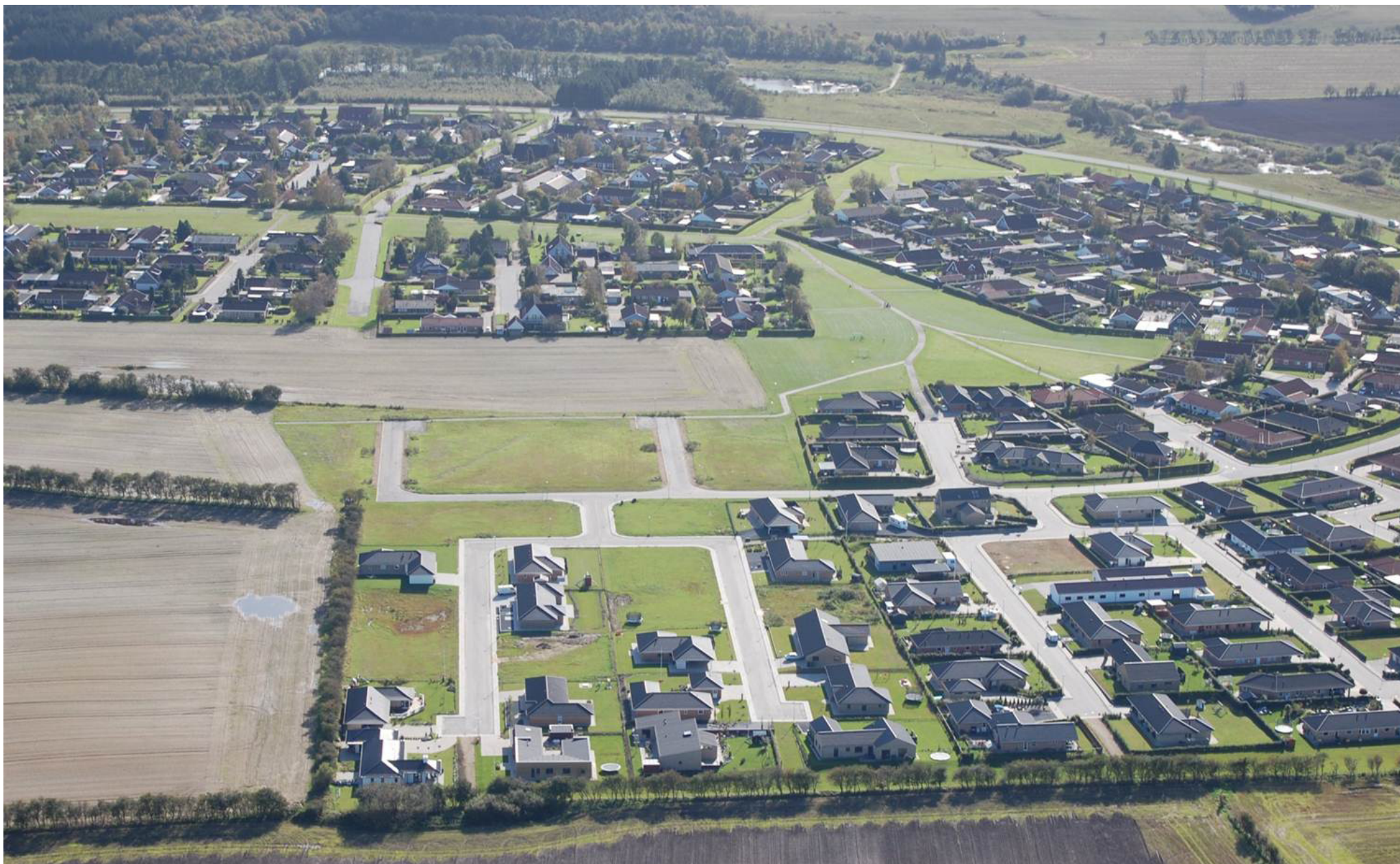
Dyssebakkevarteret set fra nord. Landskabeligt smukt anlagt boligområde med adskilte veje og cykelruter. Foto: Haderslev Kommune, 27 sept 2011
